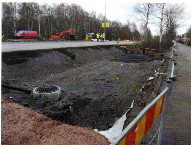
Ensimmäinen biohiili-sepeli-seos levitettiin Espoon Merituulentielle rakennettavalle biopidätysalueelle marraskuussa 2017.
